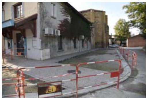
Aménagement de places de parking
