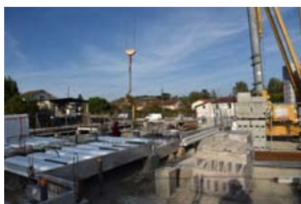
Le chantier de la maison de santé
